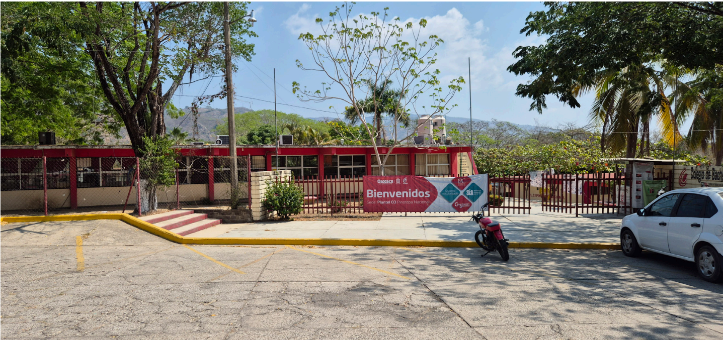
Fotografía de las instalaciones del COBAO
