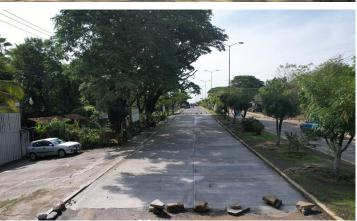
años por la falta de mantenimiento, esta ocasión se optó por levantar y retirar toda la carpeta asfáltica dañada y sustituirla por concreto hidráulico, además de colocar una base de pedraplén con piedra bola, para garantizar una mayor durabilidad y un trabajo de calidad en beneficio de las y los pinotepenses.
